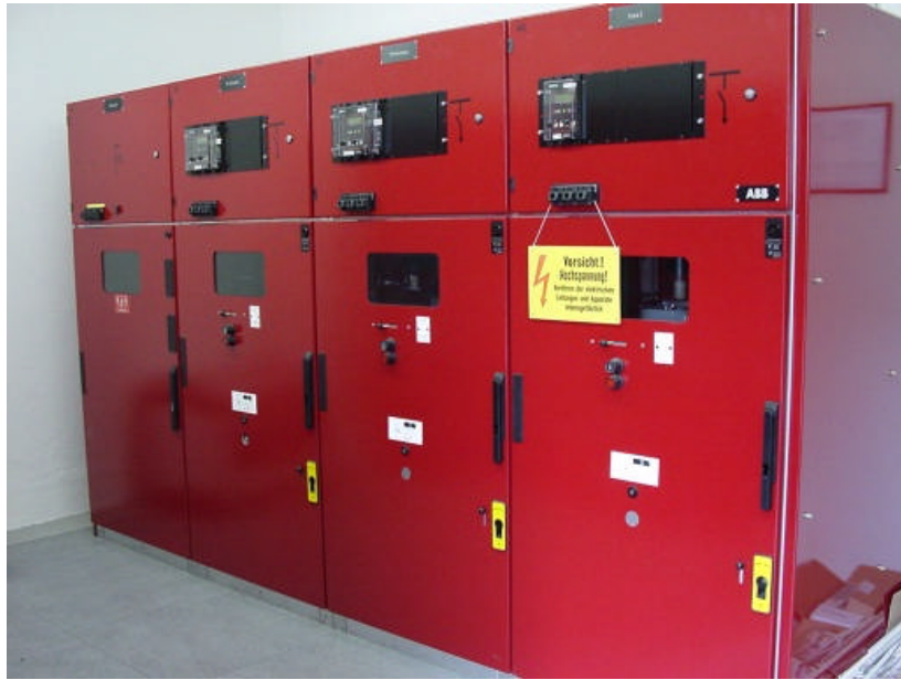
Mittelspannungsschalter
